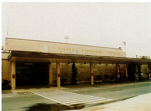
▲ パッセンジャーターミナル
