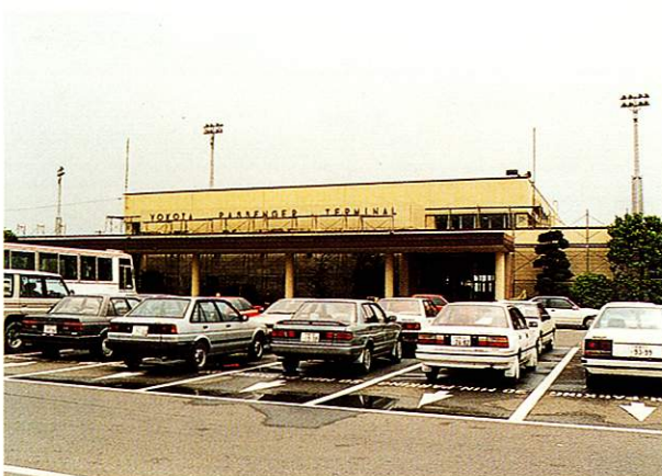
▲ パッセンジャーターミナル
