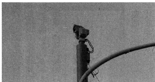
▲光ファイバー使用の河川管理用カメラ (永田橋付近)
