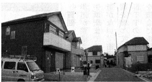
▲建築中の住宅
