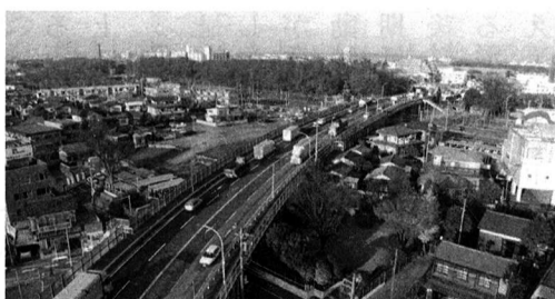
▲拡幅される武蔵野陸橋
