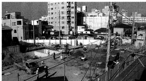
▲立体駐車場建設中の市営駐車場
