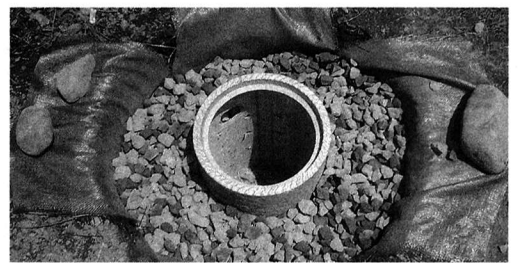
▲工事中の雨水浸透ます
