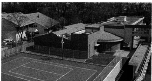
▲完成した第1中学校ランチルーム
