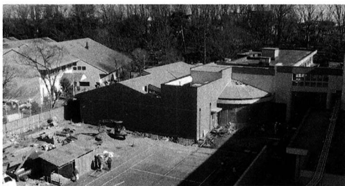
▲建設工事中のランチルーム
