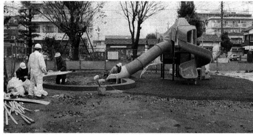
▲安全対策工事施行中（武蔵野台東公園）
