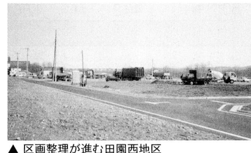
▲ 区画整理が進む田園西地区
