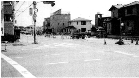
▲工事が進む内出交差点付近
