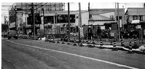
▲工事が進む「やなぎ通り」
