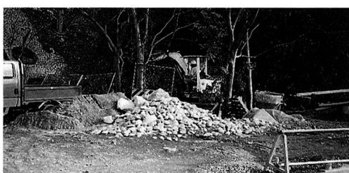
▲工事中の下の川緑地
