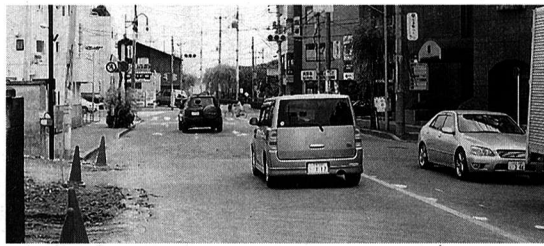
▲一部拡幅される柳通り
