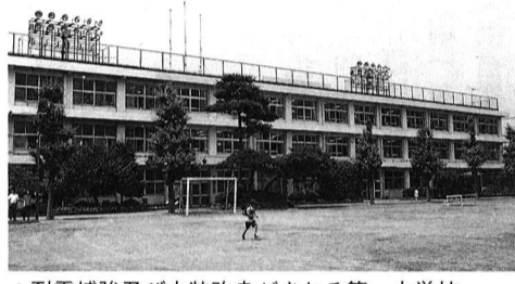
▲耐震補強及び内装改良がされる第一小学校
