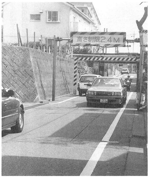
▲拡幅等の改修が望まれる五丁橋八高線ガード
