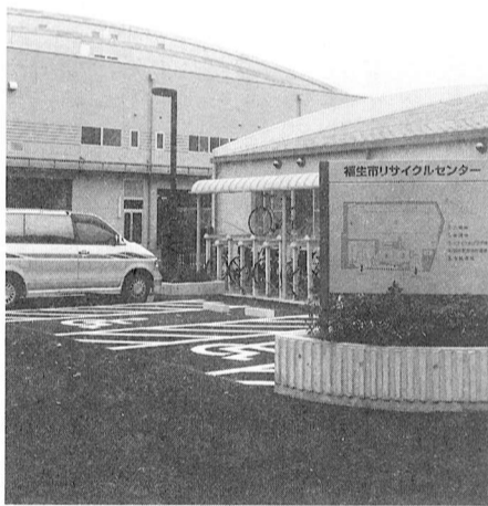
▲リサイクルプラザも完成したリサイクルセンター (熊川1562番地先)
