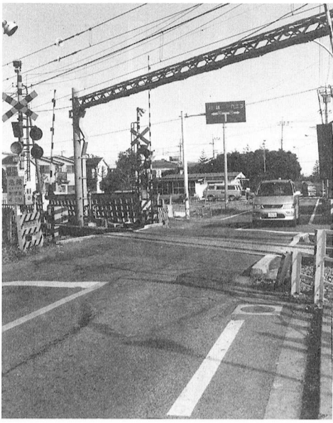
▲狭い東福生駅北側の福生第三踏切
