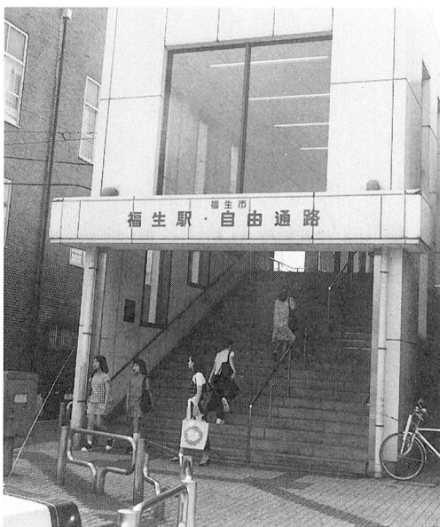
▲エレベーター等の設置が望まれる福生駅
