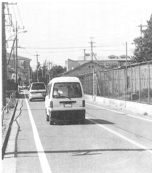
▲望まれるガードレール設置
