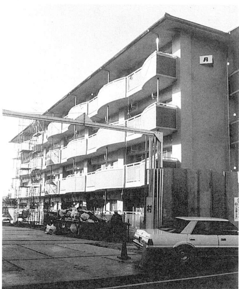
▲完成近い市営住宅
