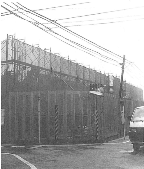
▲建設工事進む第二市営住宅
