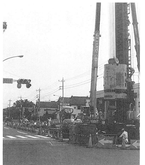
▲多摩川上流流域下水道雨水幹線事業の工事現場(市内武蔵野台地区にて)
