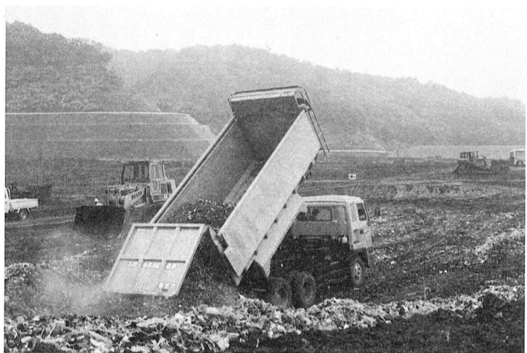
▲都26市1町で構成する西多摩地域廃棄物広域処分組合・日の出町谷戸沢廃棄物広域処分場……27市町からでる一般廃棄物を、各地の清掃工場や破碎処理施設等で中間処理をし、可燃ごみの焼却残渣と、破碎処理された不燃ごみ・焼却不適ごみを埋め立てている
