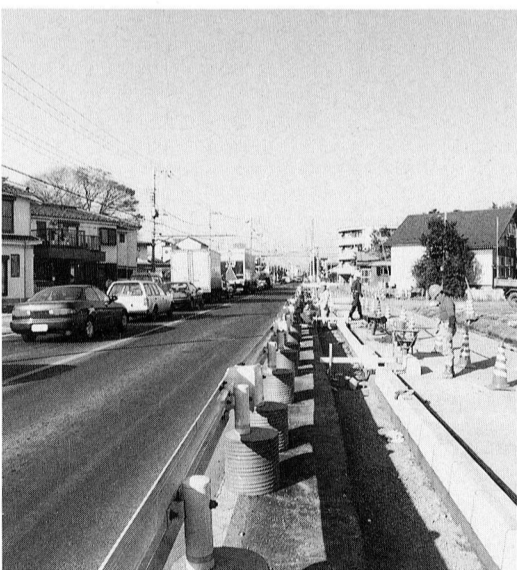
▲拡幅整備が進む奥多摩街道(熊川地区)
