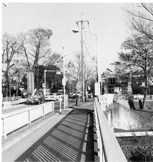
▲青梅・羽村・当市の雨水を処理する「新雨水幹線計画」では、多摩川への「はけ口」(放流地点)が柳山公園内に……
