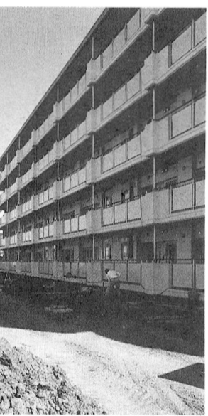
建設中の都営住宅(熊川、五日市街道沿い)
