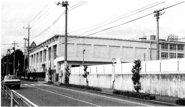
火災のあった 二中体育館
