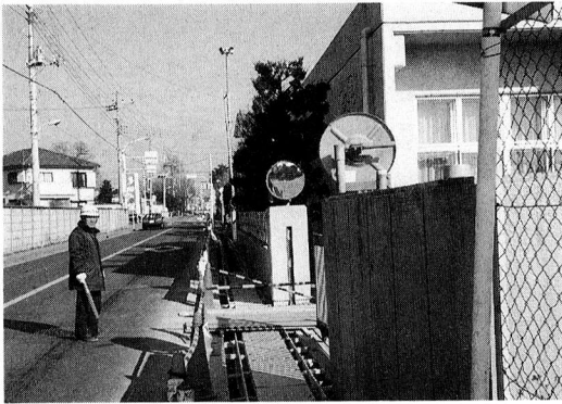
都道側溝改修工事
