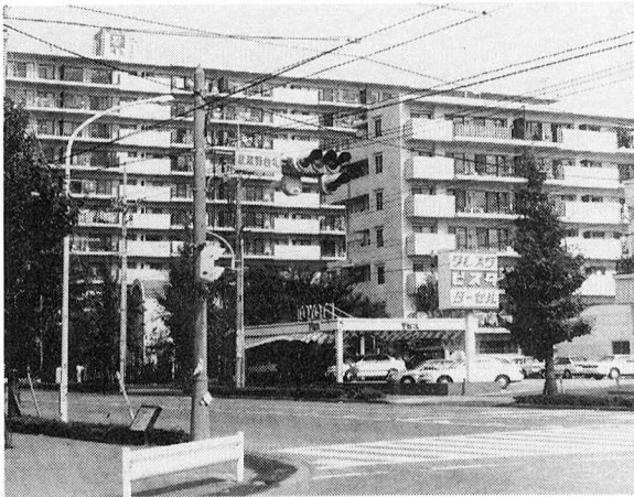
市内にみられるマンション (武蔵野台で)
