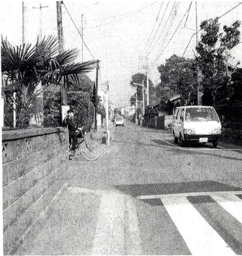
歩道と側溝が 共用されている法務局通り
