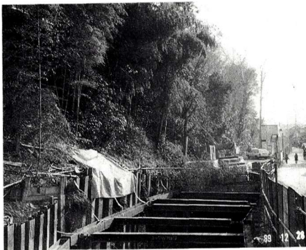
工事中の下の川
