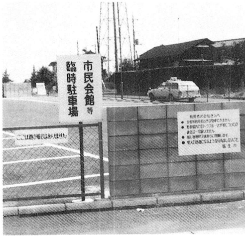
完成した市民会館臨時駐車場
