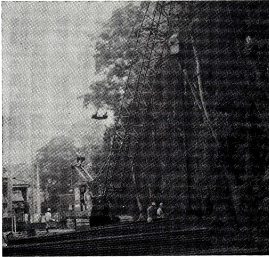
大切な緑、保護をしながら工事は進む (下の川の工事)
