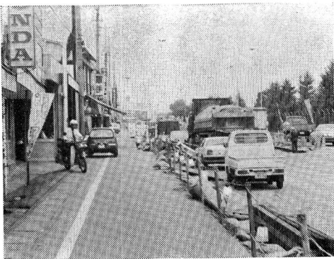
急ピッチで工事が進む
