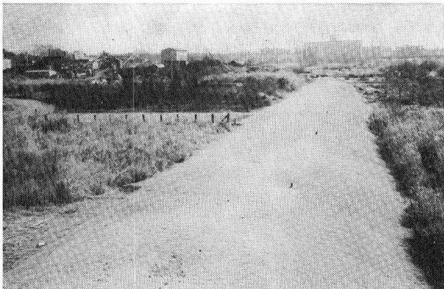
今年完成予定の多摩川新堤
