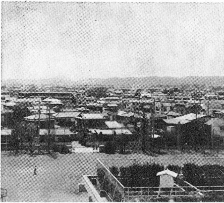
調査が予定されている熊川地区
