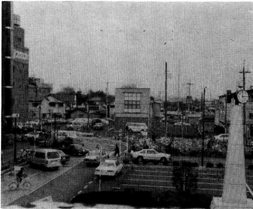
完成も間近い東口土地区画整理事業
