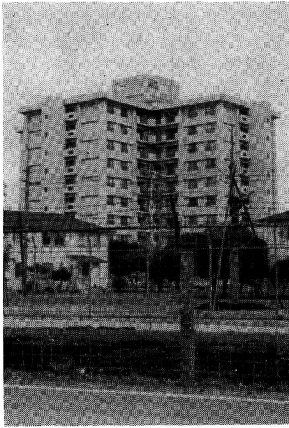
テレビ受信に影響する基地内の高層住宅
