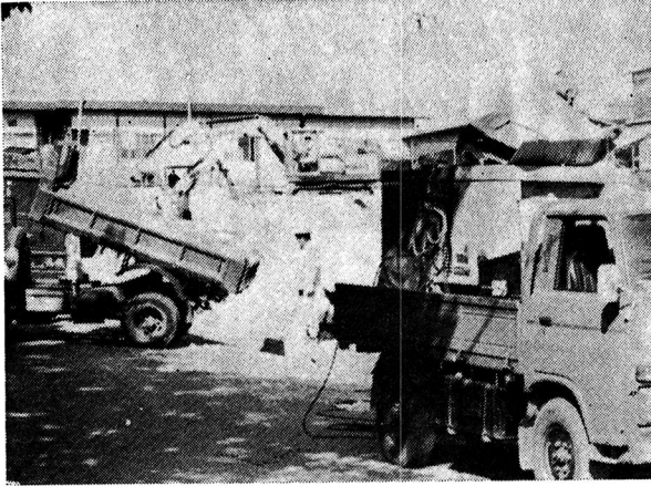
二中北側の工場誘致現場
