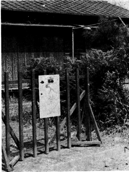
建てかえを待つ市営住宅
