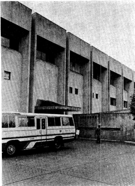
改造検討中の福祉会館
