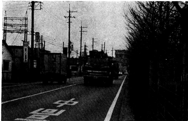
基地側に拡張される国道
