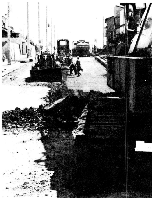
完成をめざす道路舗装工事
