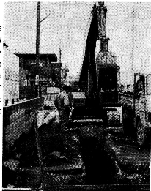
整備の進む下水道
