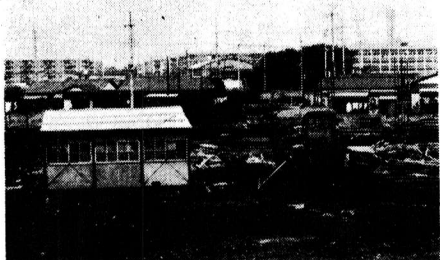
建設のはじまった第1小学校分校
