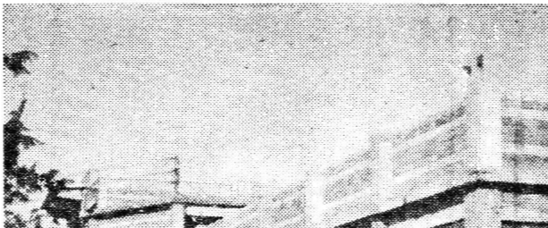
新製品 テラストーン(影射)工場完工
