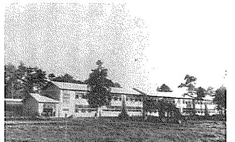
▲昭和26年11月に建設した福生第一中学校
