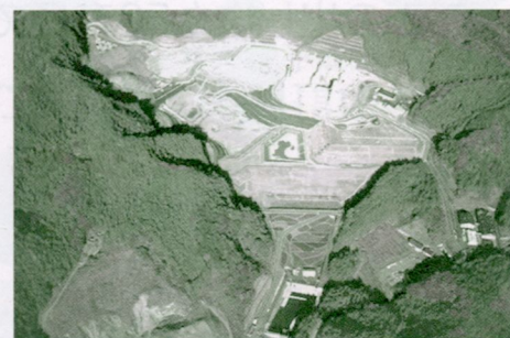
日の出町二ツ塚廃棄物広域処分場
