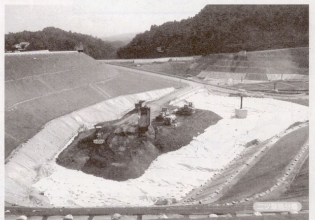
二ツ塚廃棄物広域処分場
