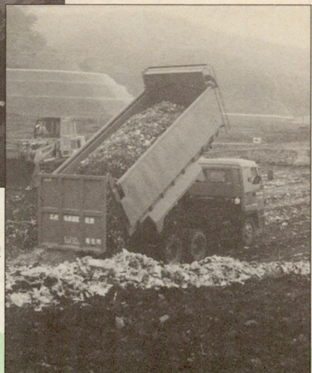
埋立作業 (日の出町谷戸沢 広域処分場)
