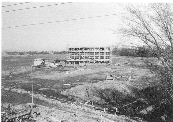
図 VI-28 建設のすすむ第5小学校
