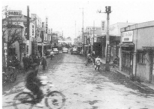
図 VI-7 広場工事着工前の駅前通り
