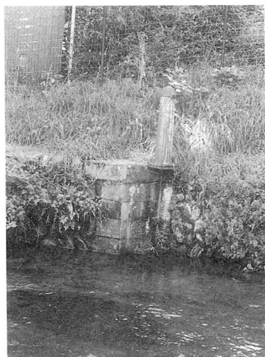
図 V-79 熊川分水取水口
