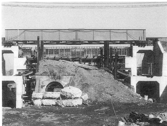
図 V-58 五日市線下の道路拡幅工事（中央に見える旧隧道）
