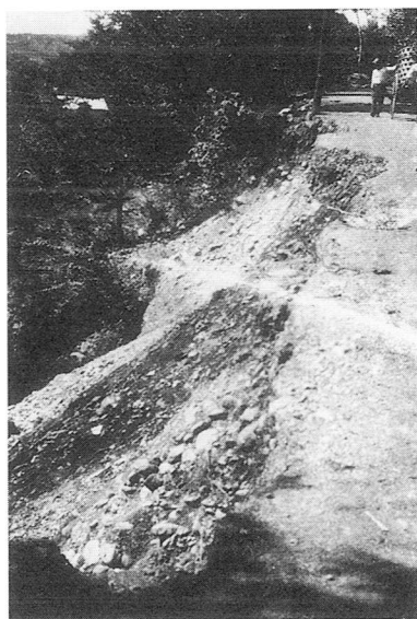
図 V-51 関東大震災で崩れた道路 (奥多摩街道) (大正 11 年 9 月 斎藤博撮影 斎藤伊左夫 家蔵)
