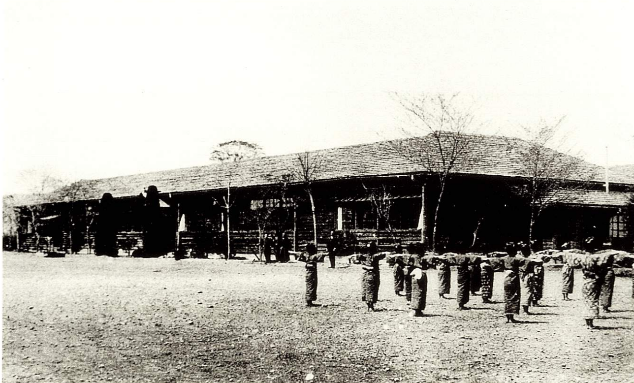
108 福生尋常高等小学校校舎 福生（現福生第一小学校） 大正期
