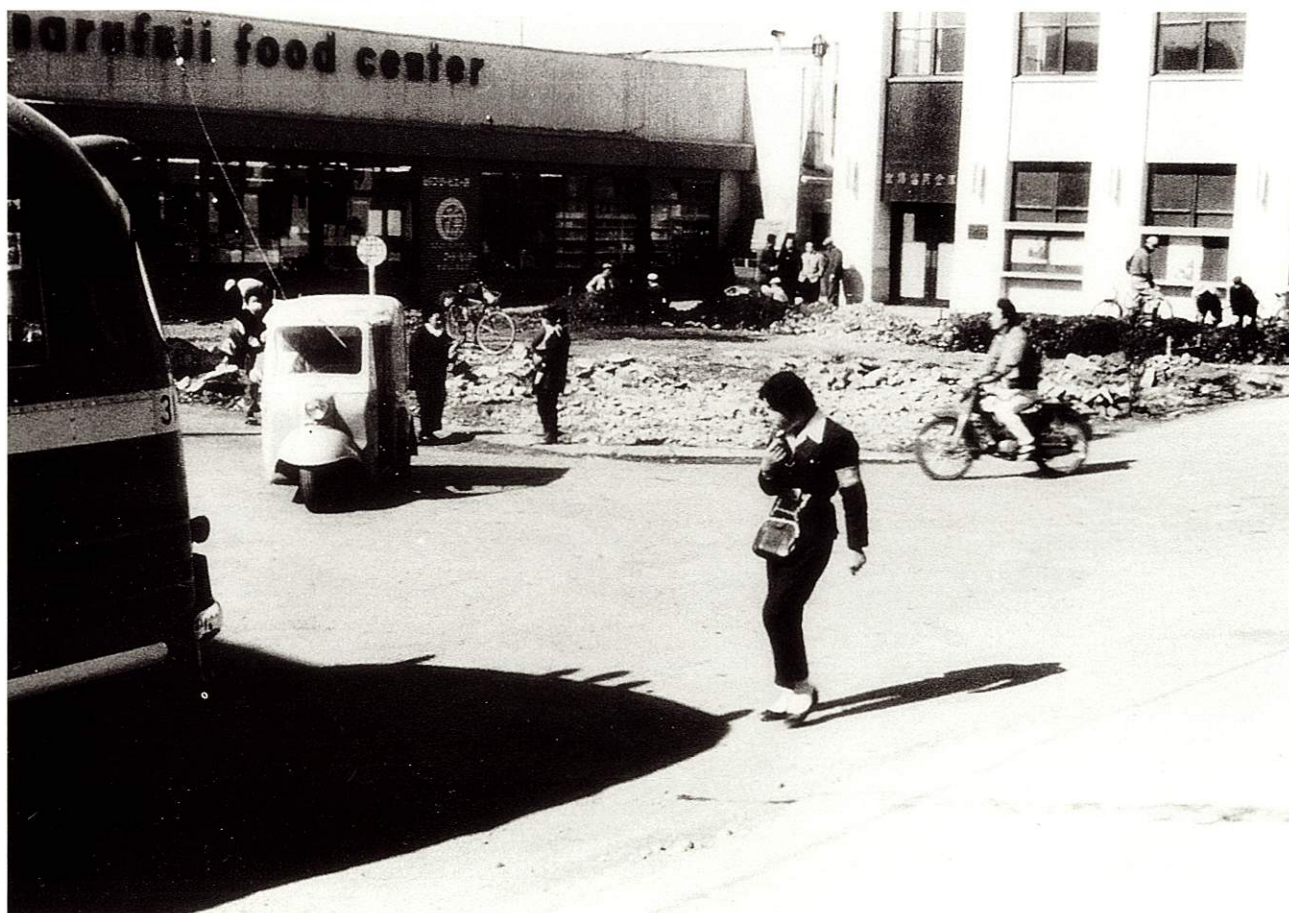
47 福生駅前広場の改修工事 福生駅前 昭和38年
