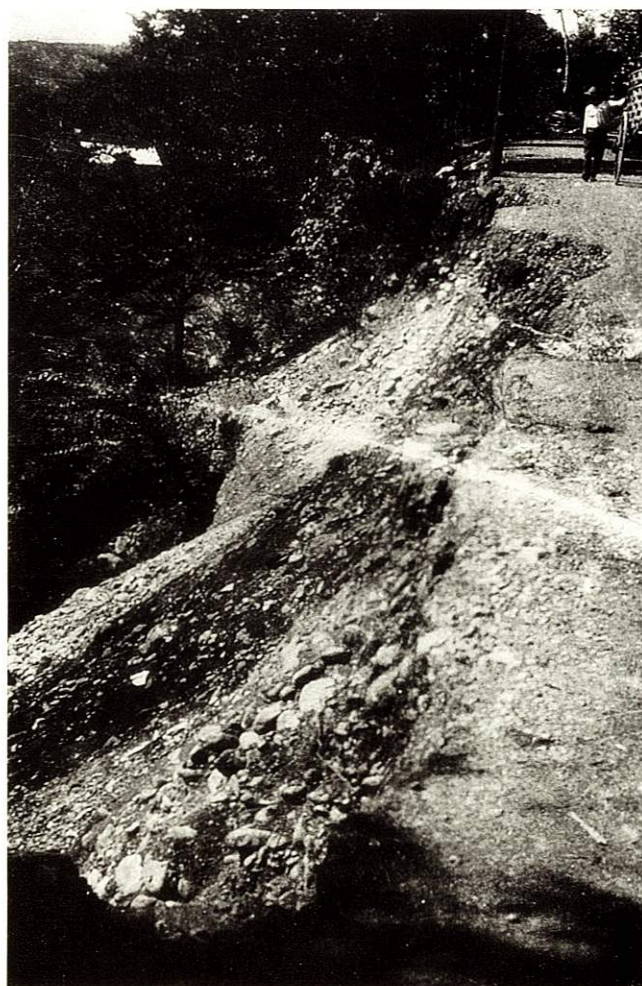
4 関東大震災のため崩れた崖 奥多摩街道 (現福生第三中学校裏付近) 大正 12 年
