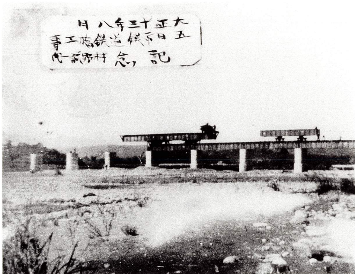
5 五日市鉄道の鉄橋架設工事 多摩川鉄橋 大正13年8月
