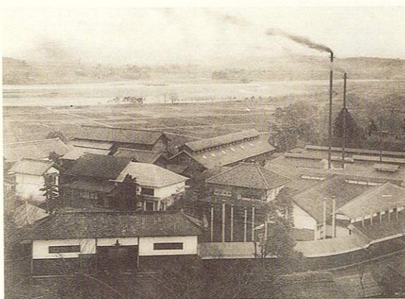
森田製糸所全景(大正期) 東方から製糸所を撮影、後方に多摩川、そして奥多摩の山々をのぞむ。大正3年、森田製糸工場の蒸気機関は二つで、16馬力、水力2馬力となっている。
