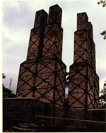
■ 富士山反射炉 (静岡県富士山市) 幕末になると大砲が大型になり多量の鋳金が必要となり、幕府はオランダ流の冶金炉の一種である反射炉を1856年(安政3)に完成する。
